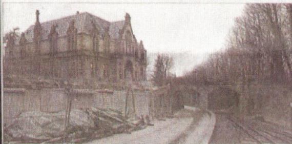
Über diese Brücke führt künftig der Weg auf das Gelände von Schloss Drachenburg, sodass die Vorburg ihren Namen wieder zu Recht trägt. An der Einfriedungsmauer wird bereits gearbeitet. FOTO: HANDT
