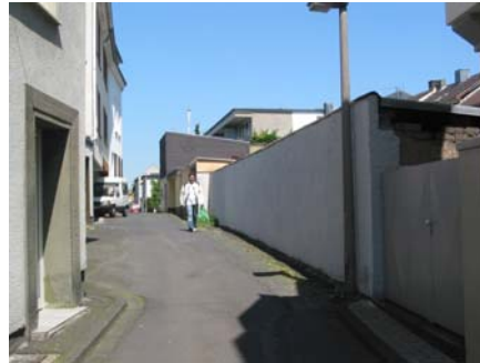
Einfache verputzte Garten- oder Hofmauer im Bereich der früheren Grabenzone.
